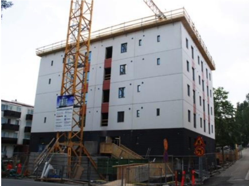
Fig.19: Kuopio zero energy building under construction (Käkelä, P., Viitanen, A. and Finnäs, K., 2013, p.4).
