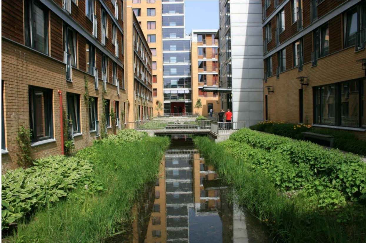
Figur 42: Fordrøyningskanal i Bjølsen studentby (Hedmark Fylkeskommune, 2013)
