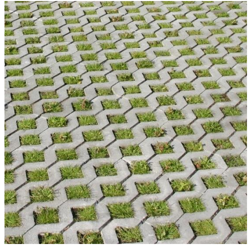
Figur 26: Eksempel på gressarmering
