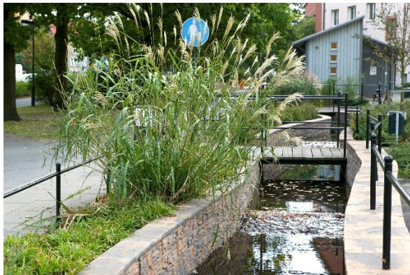
Figur 23: Eksempel på en kanal som går gjennom et boligområde i Augustenborg
