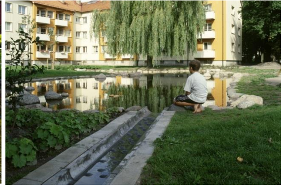
Figur 37: Åpen renne til dam i Augustenborg (Steriks, u.å.)
