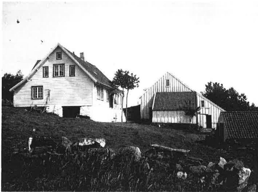
Frå Østabøgarden på Sør-Talgje. Bildet er teke i 1912 og bygningane er frå 1800-talet. Foto: Wilse. Tilhøyrrer Stavanger Museum.
