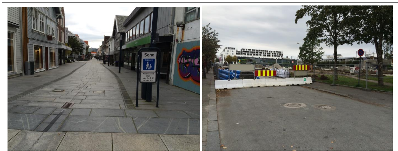
Eksempel bilder med tiltak for å hindre trafikk i Langgata og anleggsområde for «Nye Ruten» (Foto: T.H. Corneliussen -19)
