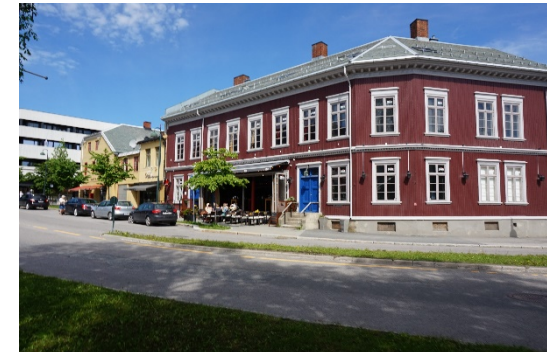
Bilde 17. Fasade C- midt mellom
