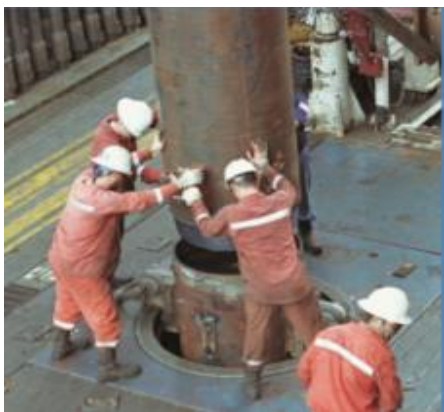
Figur 4 viser manuell håndtering av conductor på boredekk
