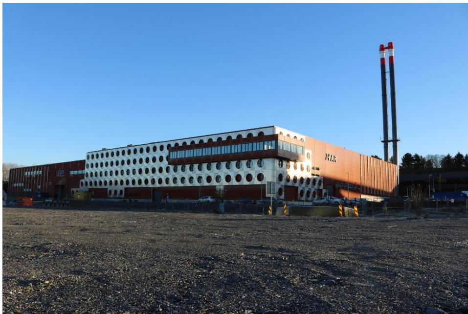
Figur 12: Etersorteringsanlegget på Forus. Til høyre på bildet kan man skimte deler av båndet som frakter avfallet til forbrenningsanlegget ved siden av.
