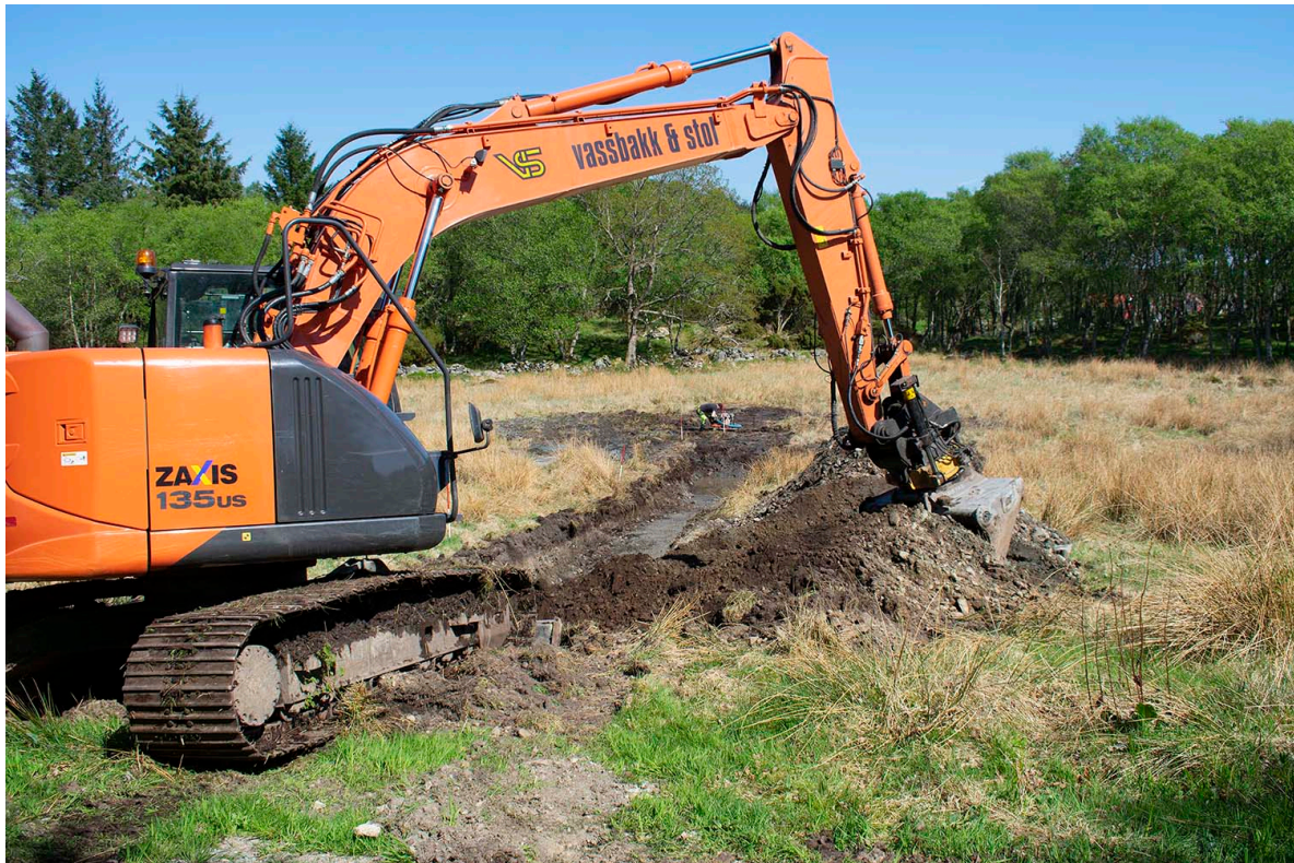
Figur 12: Gjenlegging av sjakt 16800. Daniel pakker sammen pumpa. Foto mot øst av C. E. Jensen.
