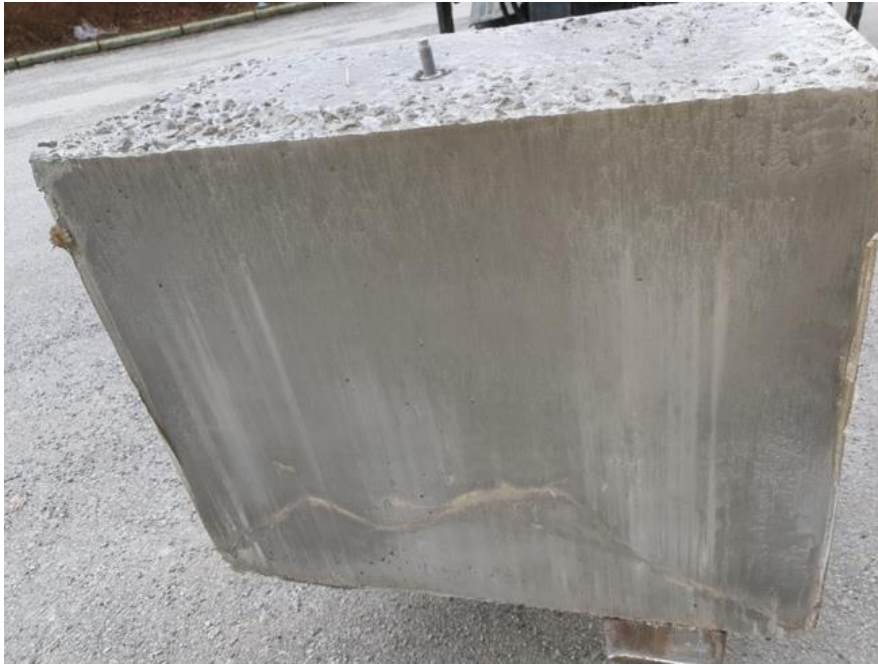
Figur 41: Overflate av betongelement FA15
