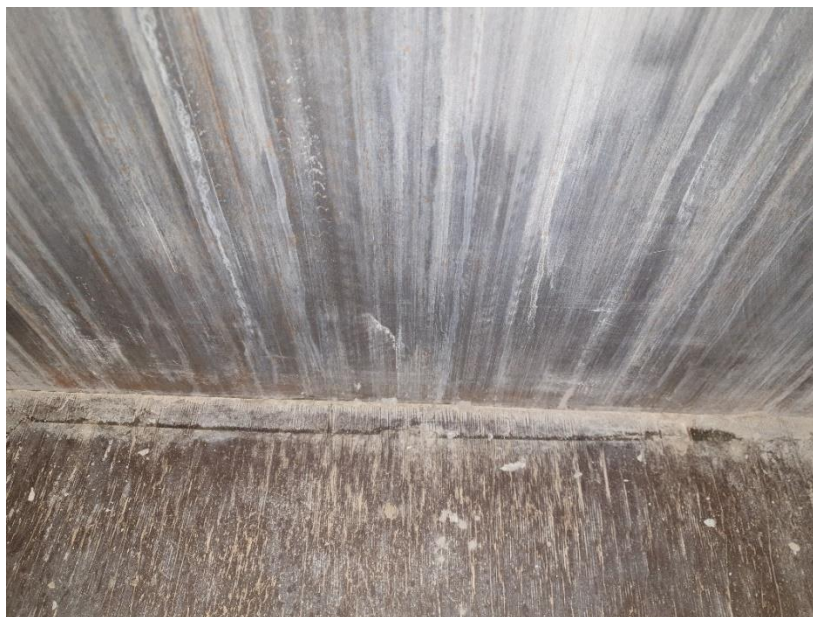
Figur 46: Tilslagspartikler skilt mellom betongbeholder og glidepanel
