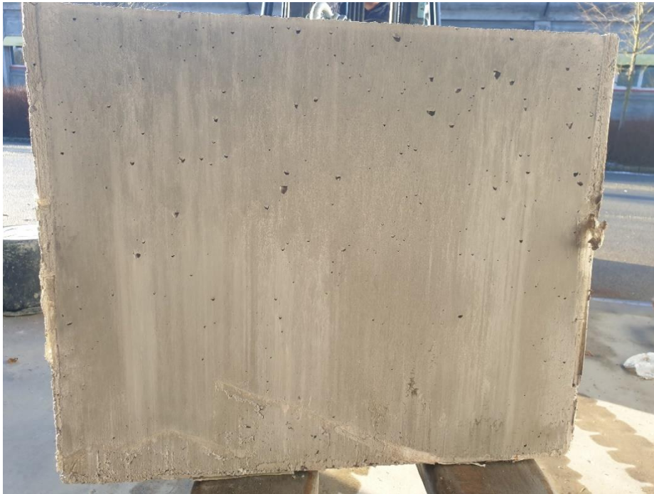
Figur 44: Overflate av betongelement BS30
