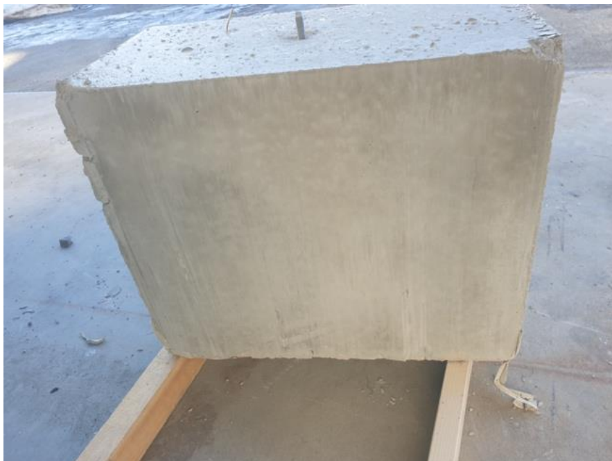
Figur 45: Overflate av betongelement BS70
