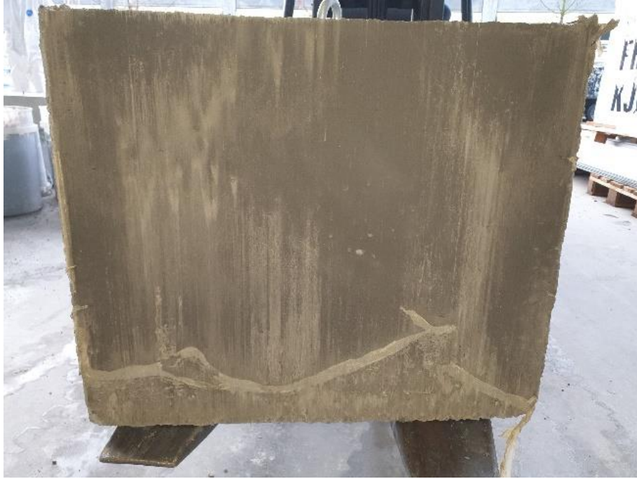
Figur 43: Overflate av betongelement FA50
