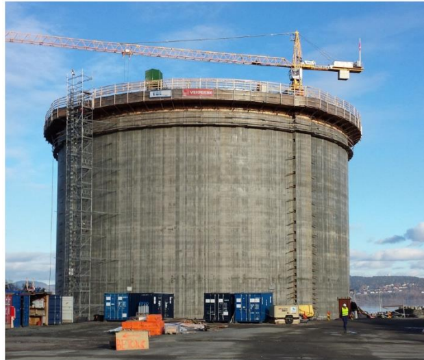
Figur 9: Glidestøping av en LNG-tank [45]
