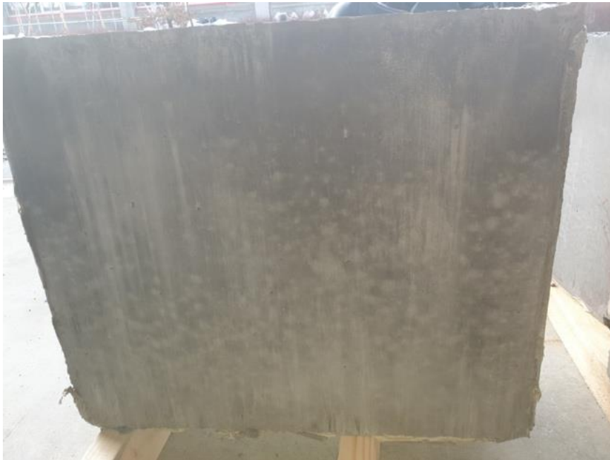
Figur 42: Overflate av betongelement FA35
