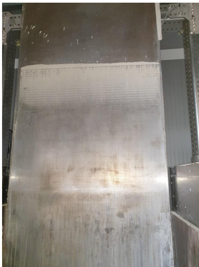
Figur 47: Groing på glidepanel etter fullført glidestøp
