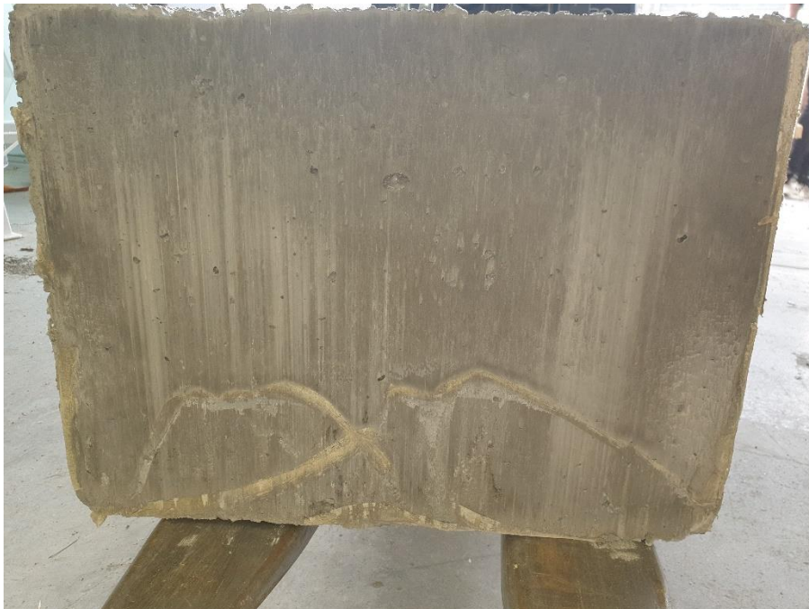
Figur 40: Overflate av betongelement SF6
