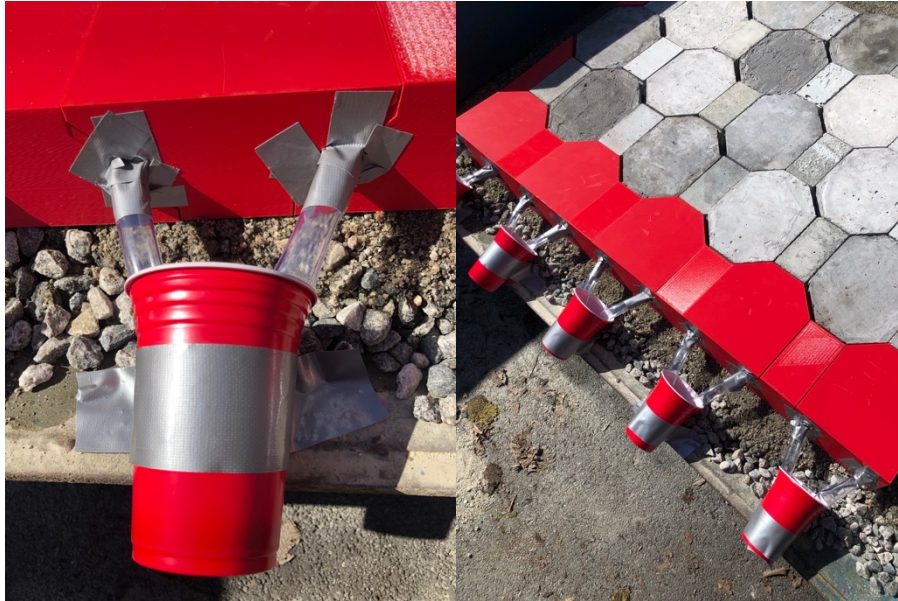
Figur 120: Plastrør festet til hulrommene, og oppsamlingskopper plassert.
