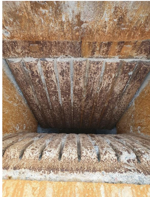
Figur 46 - Innsiden av kjeftknuser
