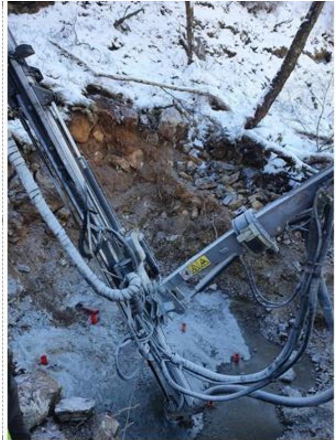
Figur 15 - Boring med helning
