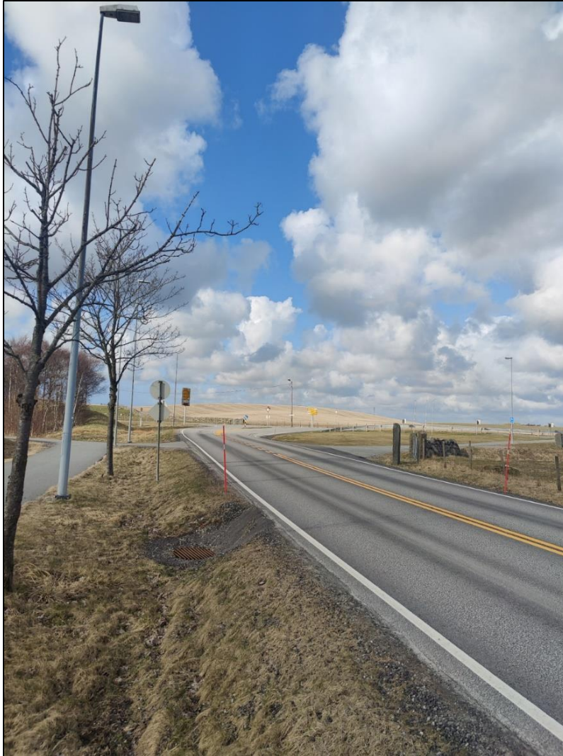
Figur 4-26 Bilde av eksisterende situasjon
