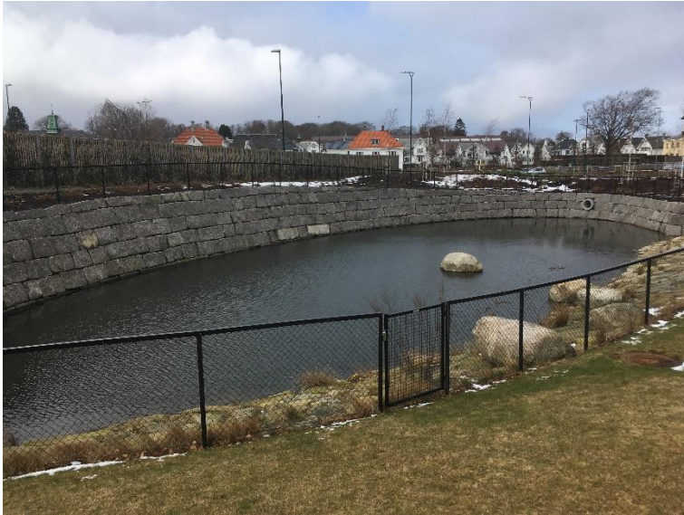
Figur 74 Eksempel på fordrøyningsbasseng (1) i Stavanger (kilde: foto tatt ved utflukt)
