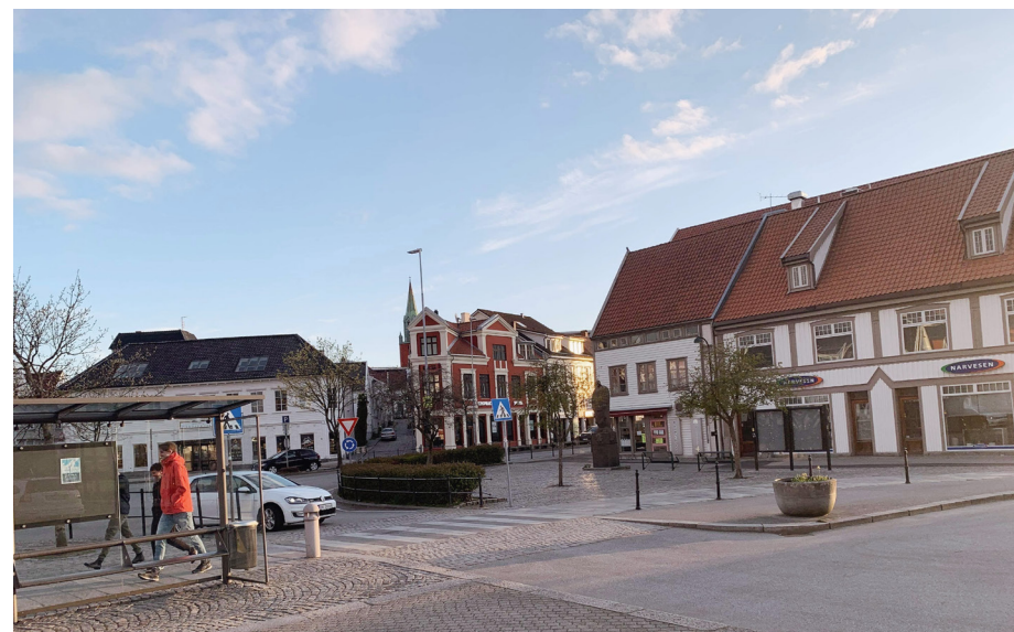
Figur 80: Åpen flate mellom terminalbygget, kiosk og bussholdeplass
