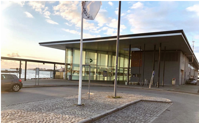
Figur 29: Bilde av dagens terminalbygg på Fiskepiren.
