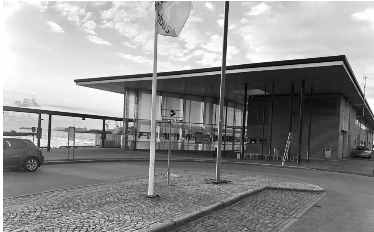
Figur 71: Terminalbygget på Fiskepiren
