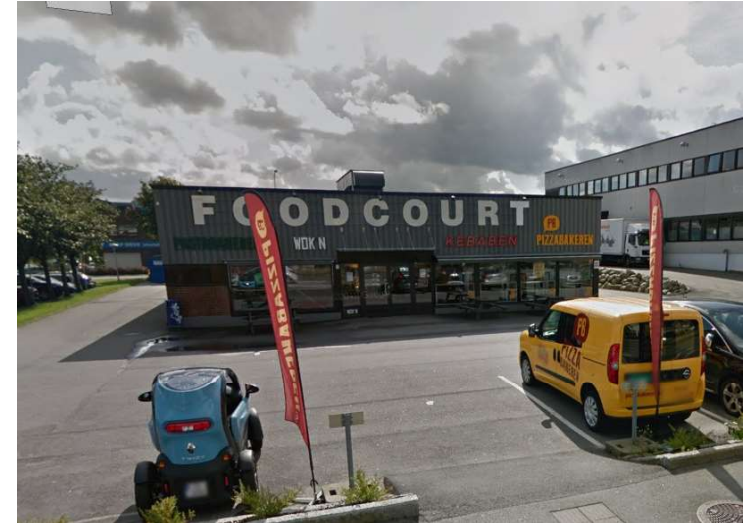
Figur: 4.52: Fasade 4: Vennlig fasade. Food Court. Her er det god kontakt mellom inne og ute gjennom flere vinduer på gatenivå. En mindre enhet sammenlignet med bebyggelsen rundt. (Google maps, 2021)
