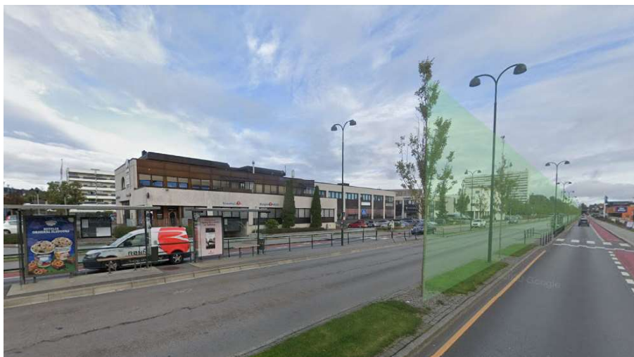
Figur 4.46: Trærne og de vertikale elementene skaper en visuell barriere (Google maps, 2021)
