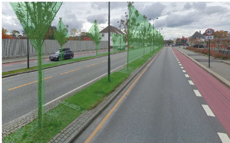
Figur 4.6 : Det er rikelig med innslag av naturelementer. Dette forsterker bussveiens estetiske kvalitet (Google maps, 2021)
