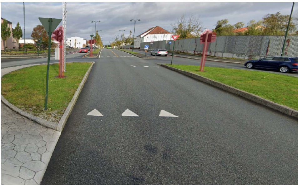
Figur 4.5 : Det er plassert trafikklys i rundkjøringene for å gi bussen første prioritet, dette fremmer bussens funksjon til å være et nøyaktig kollektivsystem (Google maps, 2021)
