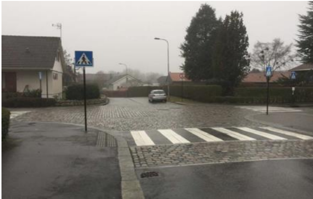
Figur 6: Brosteinskryss laget med bitumenperler i Stavanger
