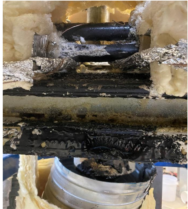
Figur 17: Utskåret tunnel med varmekabler isoolert med aluminium
