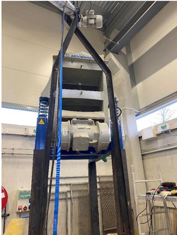
Figur 12: Støtte laget av stålstenger for å holde transportskruen på plass
