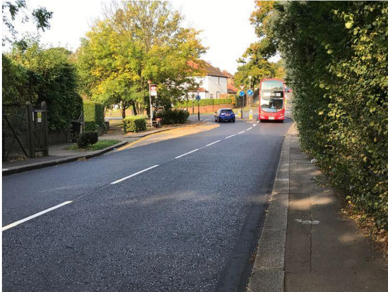
Figur 2: Asfalt laget med resirkulert plastikk i Storbritannia
