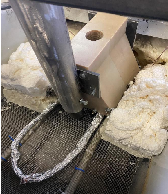
Figur 16: Innsnevring ved hjelp av fugeskum med varmekabler isolert med aluminium
