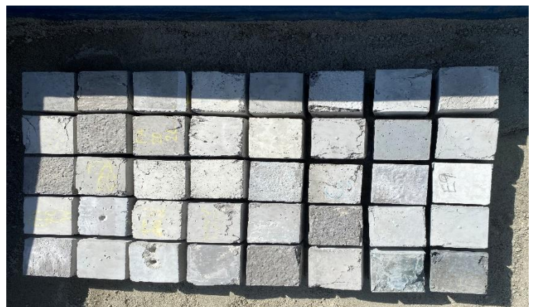
Figur 20: Brosteinsti av betongklosser
