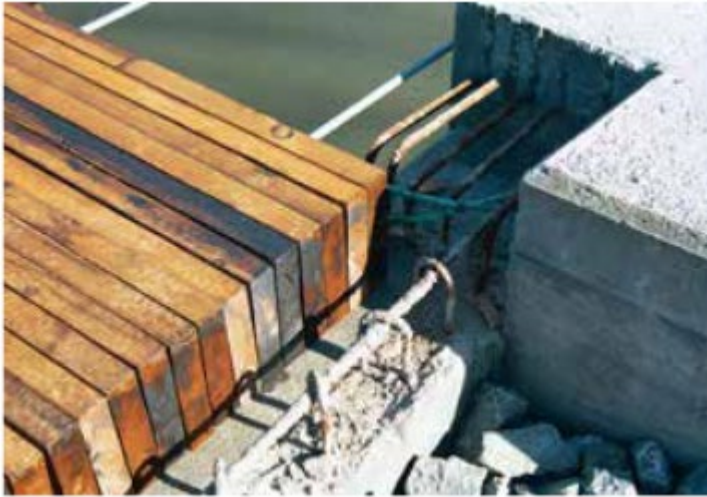
Figur 2.8: Tverrspent dekke fra Møllendammen bru [18]
