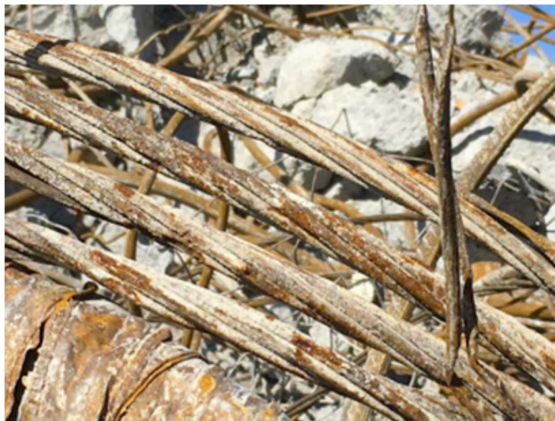
Figur 36: Groptæring på førøppspente spennkabler [61, fig. 2]
