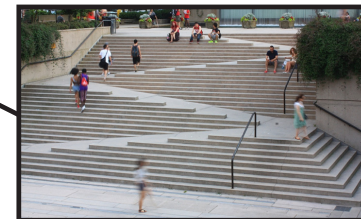
Figur 208: Integrert trapp og rampe som er universelt utformet (Fotoeins Fotografie, 2013)
