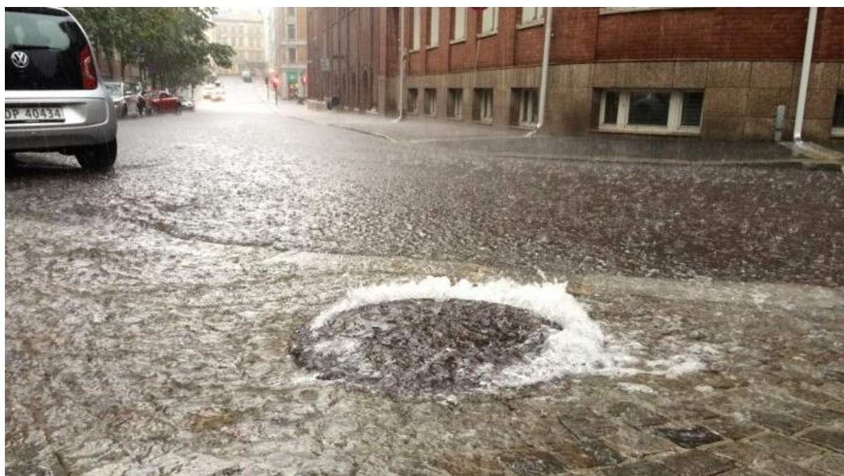
Figur 3.1: Kumlokket danser på grunn av overvann, Fra: Cowi setter fokus på overvann, (Byggeindustrien, 2015) foto: Svanhild Blakstad, 2015
