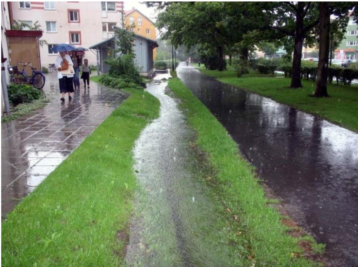
Figur 3.12: Bilde av en vadi ved en nedbørshendelse. Fra: Overvannstrategi for fremtiden , (Åstebøl, 2017), s. 8, Foto: Malmø kommune,
