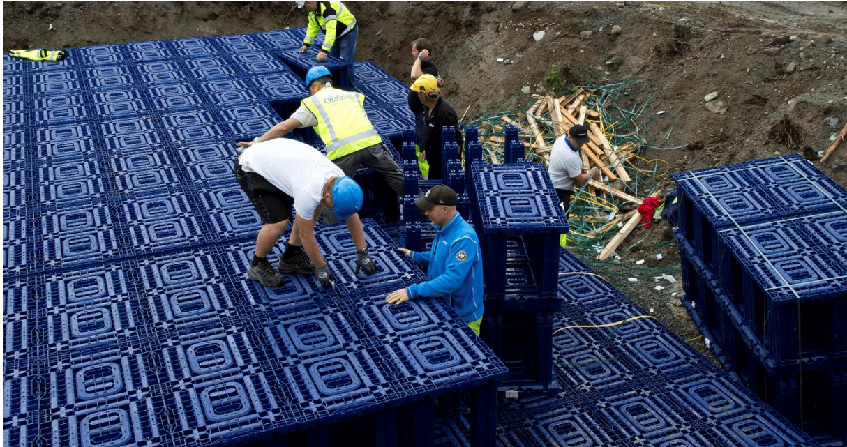
Figur 3.10: Montering av et plastkasettmagasin for fordrøyning av overvann. Fra: Norges første Q-Bic Plus anlegg montert på Gran, (Wavin, u.å.).
