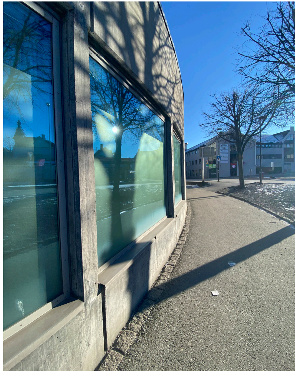
Figur 172- Bygget ligger tett opp til fortauet, og har store vinduer med potensial til å skape gjennomtrengelighet.
