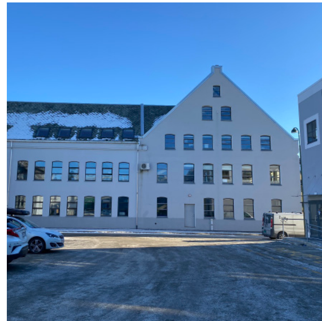
Figur 67- Kvitsøygata 10, renovert hermetikkfabrikk.
