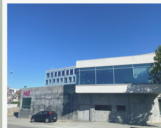
Figur 74- Det gamle BI- bygget, sett fra front.
