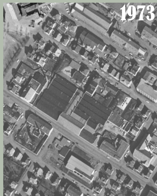
Figur 60- Flyfoto av Skanem- kvartalet i 1973, før transformasjonen av kvartalet (Utklipp fra finn.no)
