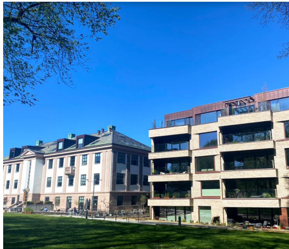
Figur 23- Ledaal Park er et eksempel på et godt samspill mellom ny og gammel bebyggelse, hvor bygningene kommuniserer med hverandre fremfor å konkurrere.
