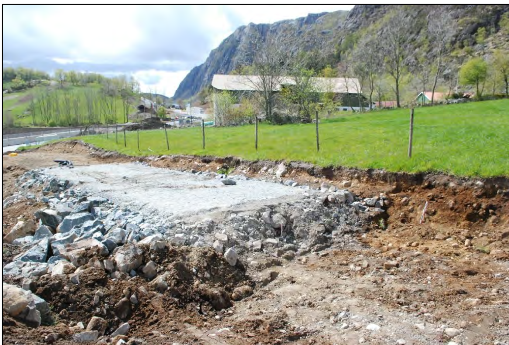
Figur 35 Underveis i fjerning av anleggsveien. Mot V. Foto E Bjørdal
