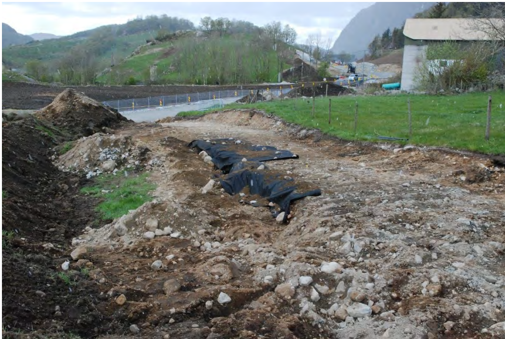
Figur 42 Status ved avsluttet undersøkelse, man ser området med str. 50411/50433 tildekket med fiberduk. Mot V. Foto E. Bjørdal
