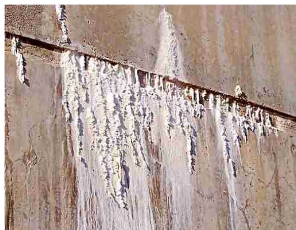
Figur 18: Utluting på betongens overflate
