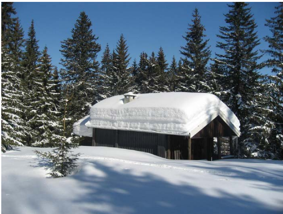
Figur 42 – Snølast på tak
