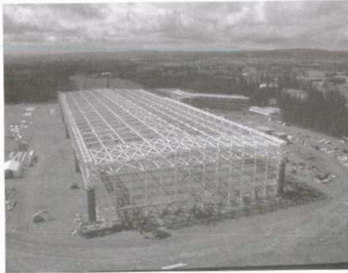
Figur 96 - SAS-hangar på Oslo lufthavn
