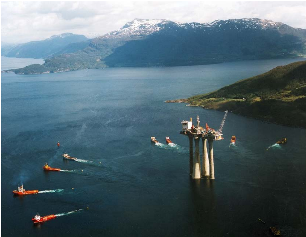
Figur 92 – Slepning av Troll-A
