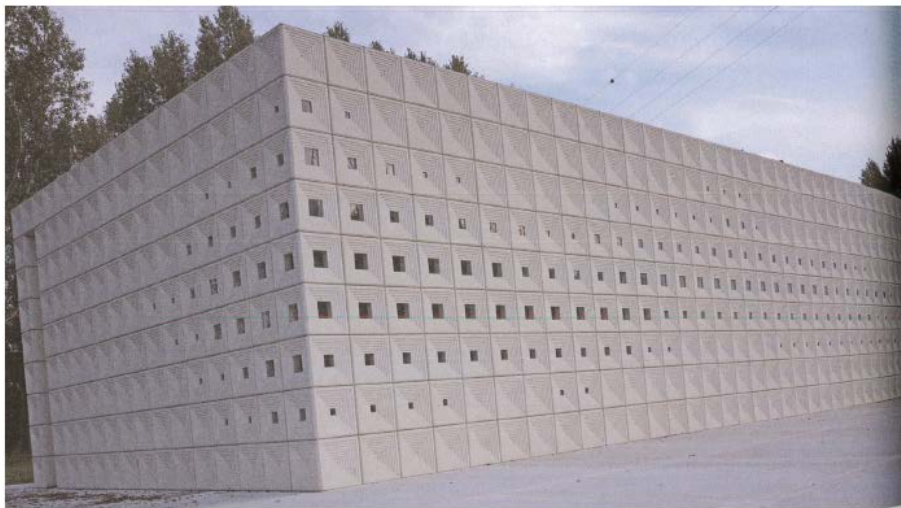
Figur 27 – Mønster i betong
