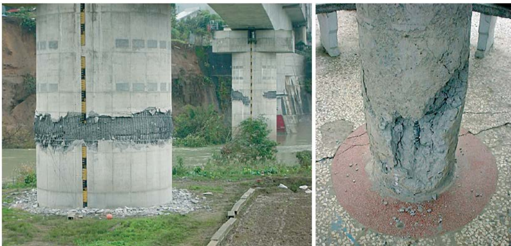
Figur 52 – Eksempel på duktilt brudd
