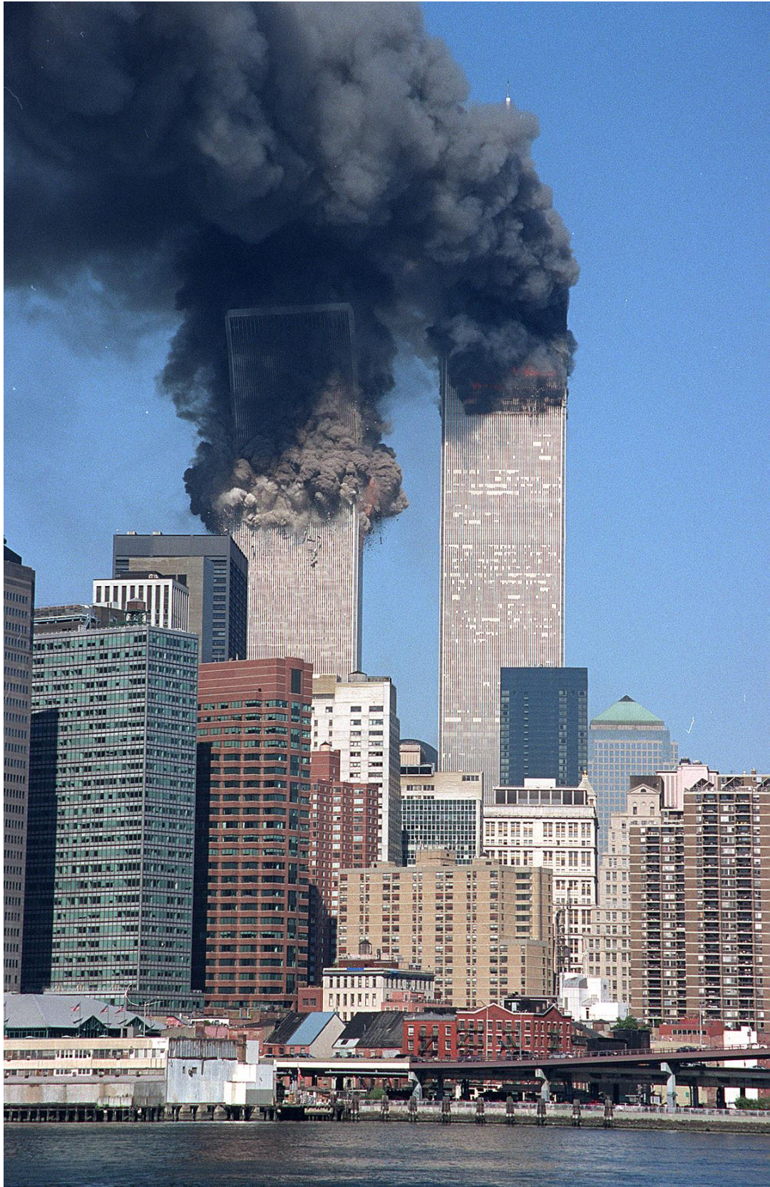
Figur 88 – Kollaps av World Trade Center, New York 2001
