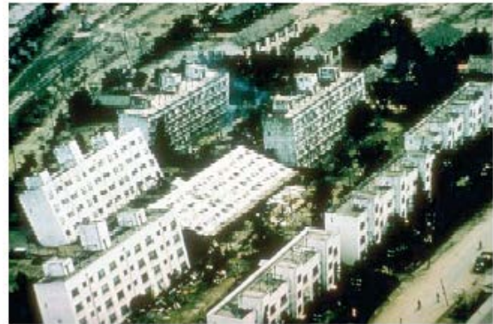
Figur 48 – Fundamenteringsbrudd
