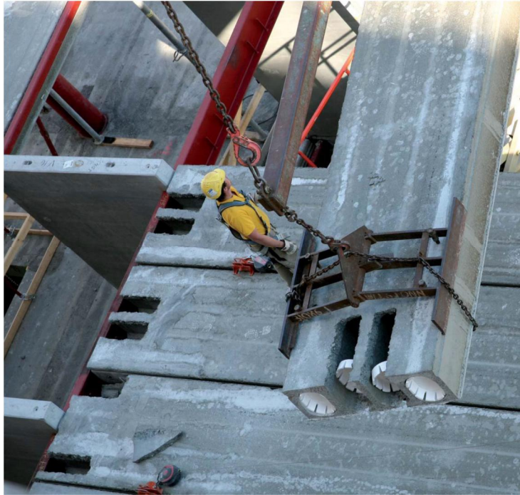
Figur 3.19 - Montasje av hulldekkeelementer – fra Norsk Stålforbunds publikasjon: Hulldekker på Stål Bæresystemer [23]
