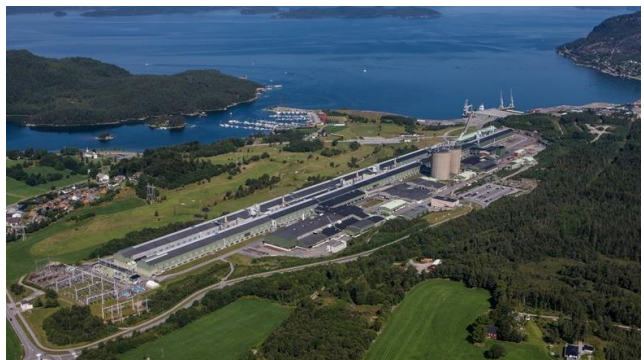
Figur 2: Hydros fabrikk på Husnes
