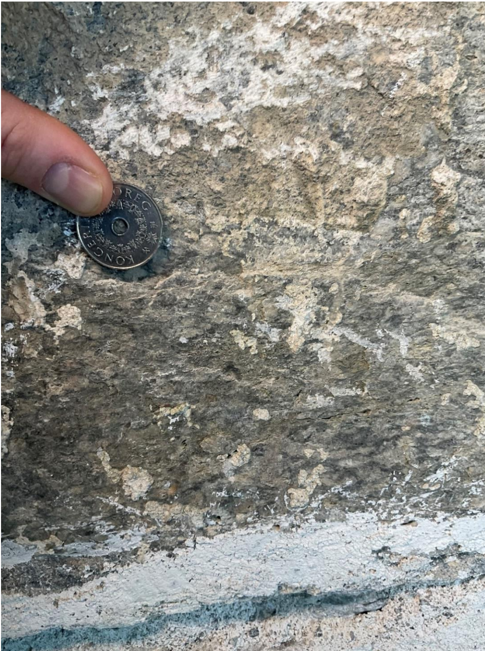
Figur 6: Avbildet er en granittisk gneis ved nordtårnet ved Domkirken. Øvre del av blokken er tildekket i mørtel, men det kan observeres en mørk hovedmasse med hvite til gråe mineraler på en størrelse 1 til 3 cm.
