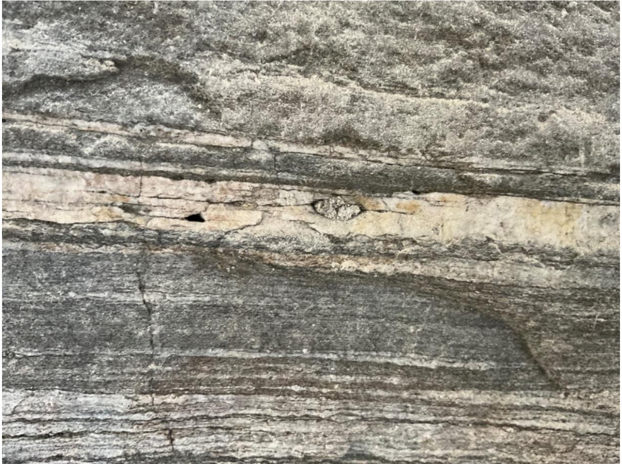
Figur 11: Blokk ved vestfasade, båndet gneis (type 5) med mulig muskovitt i kalifeltspatisk bånd.
