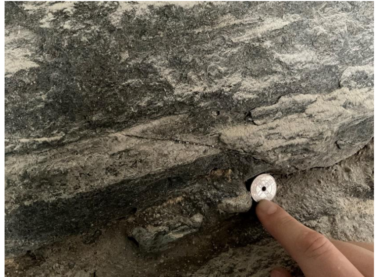
Figur 13: Tatt ved nordfasaden, viser et bånd av muskovitt som går diagonalt gjennom båndgneisen (type 5).
