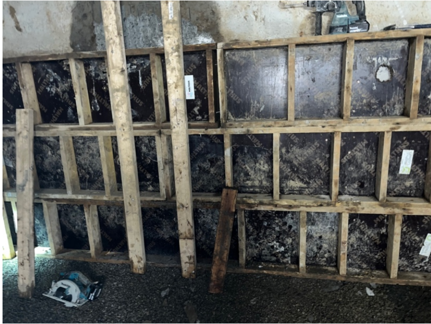
Figur 33: Forskalingskassetter 1
