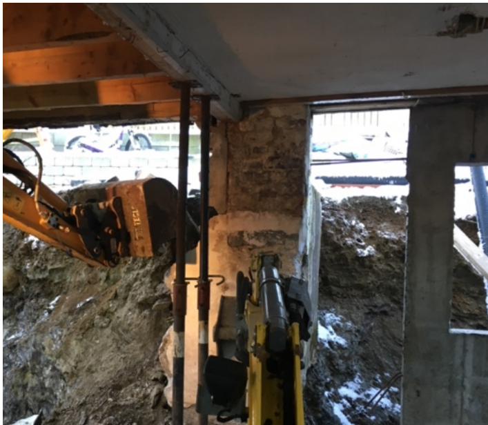
Figur 32: Riving av gammel grunnmur
