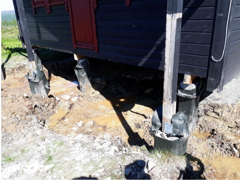
Figur 10: Konstruksjon før byggeprosessen
