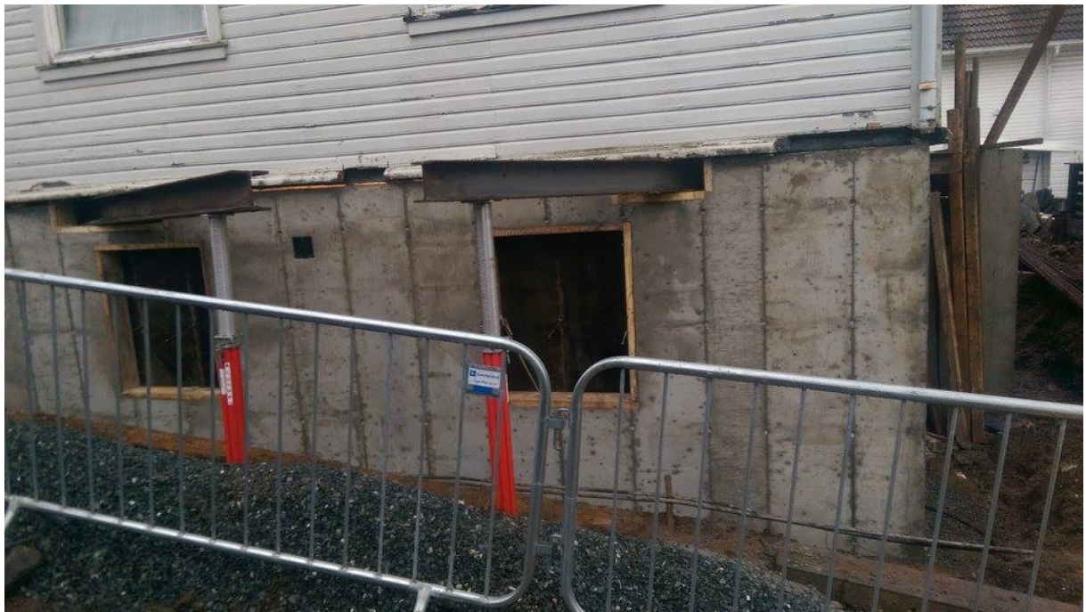
Figur 17: Eksempel 2 for midlertidig bæring ved hjelp av ståldrager
