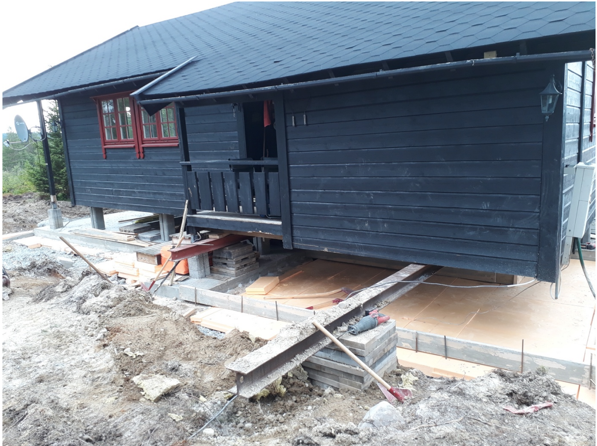
Figur 16: Eksempel 1 for midlertidig bæring ved hjelp av ståldrager
