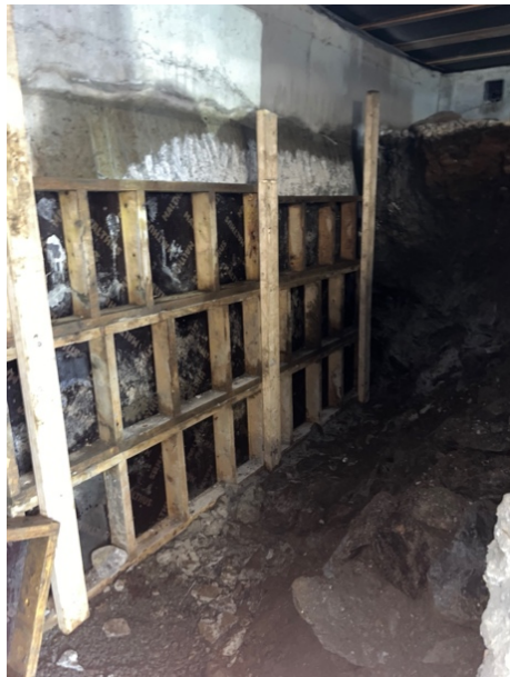
Figur 34: Forskalingskassetter 2
