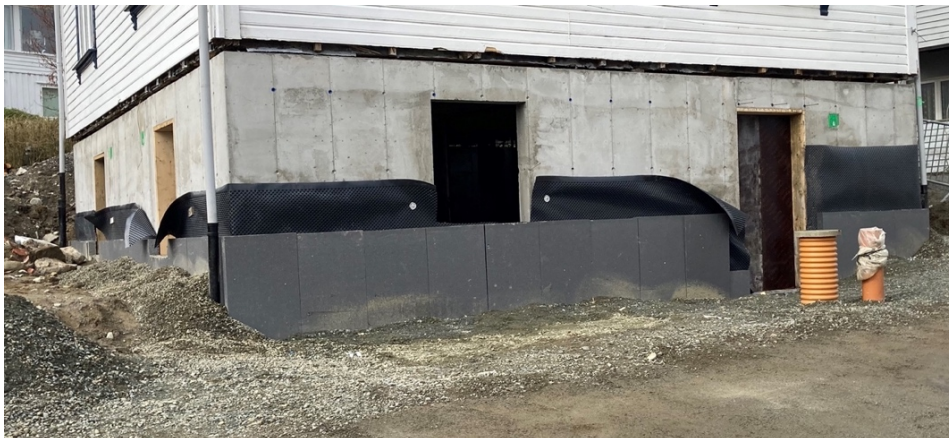
Figur 39: Isolering og tetting av kjeller
