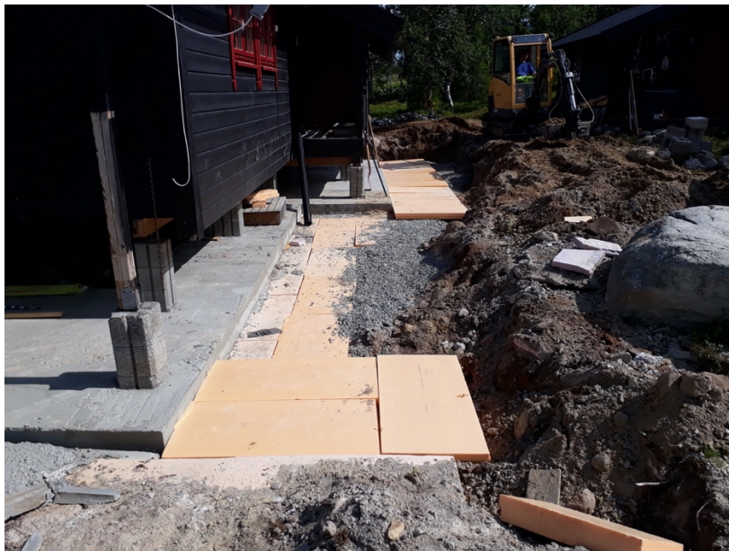
Figur 13: Bygg plassert på permanent bæring 1
