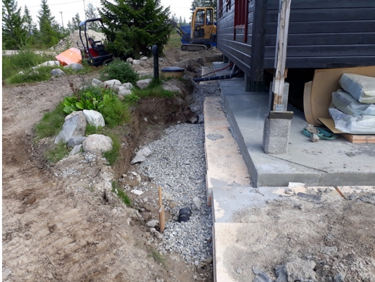
Figur 14: Bygg plassert på permanent bæring 2
