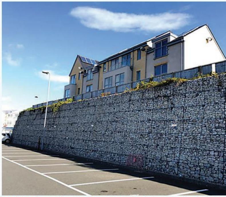
Fig. 3. Støttemur bygget med knust betong i (Newport, Isle of Wight, England) Foto: Jan Eldegard Hjelte, FABEKO
