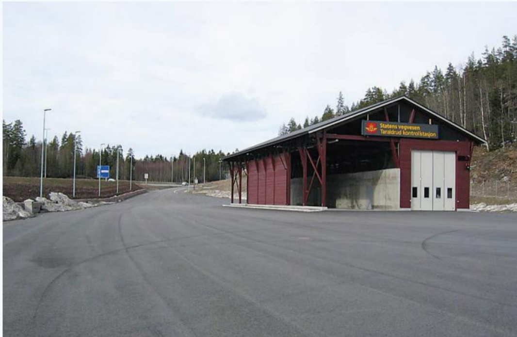
Fig. 1. I påkjøringsrampen til E6 fra Taraldrud kontrollstasjon syd for Oslo har Statens vegvesen benyttet bl.a. knust betong i forsterkningslaget. Foto. Christian J. Engelsen, SINTEF Byggeforsk
