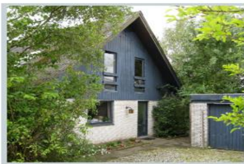
Huset før energirenoeringen(1970)
