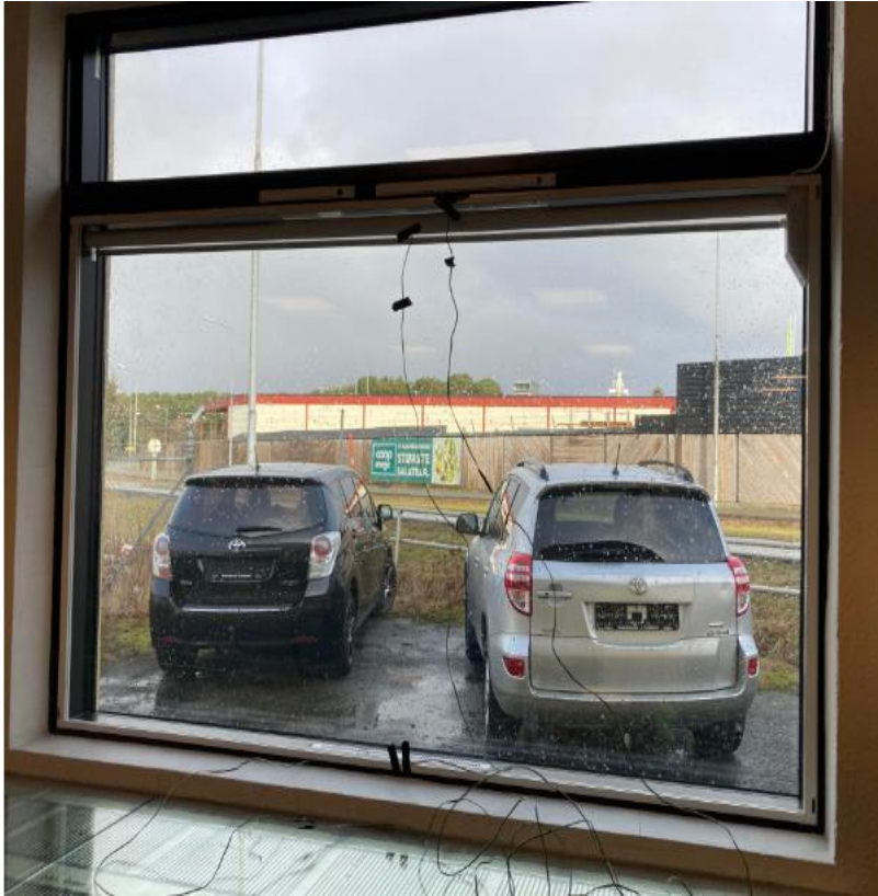
Figur 30: Dimensjon på det ventilerte dobbeltvinduet (Foto: Morris Van H Cinzah)
