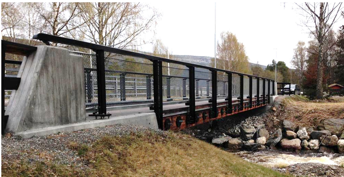
Otnes GS-Bru. 16,5 m lang platebru over elv. Rendalen kommune (2012)
