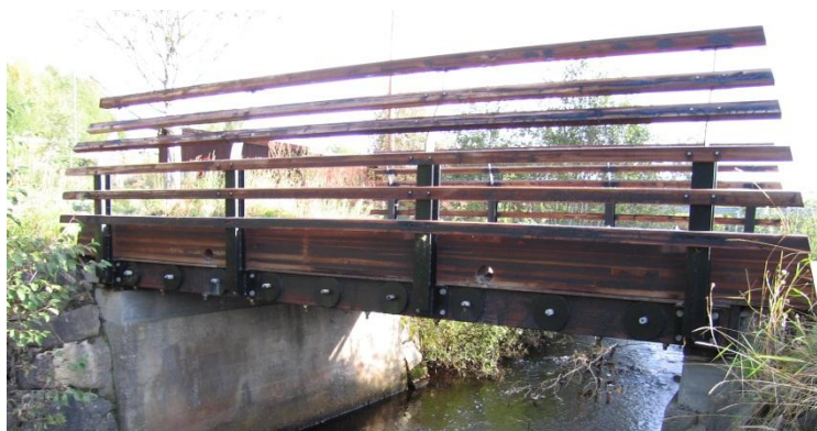
Veenslivegen Bru. GS-bru over bekk. Løten kommune (2005)
