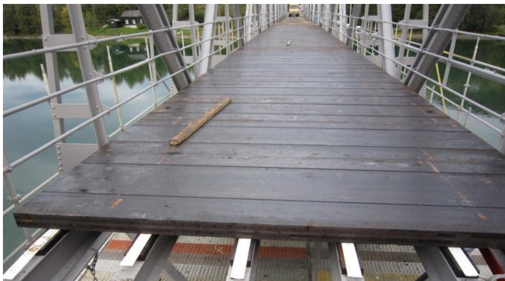
Hundorp Bru. Nytt dekke av massivtre på vegbru over Gudbrandsdalslågen. Sør-Fron kommune (2010)
