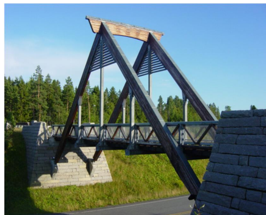
Måna Bru. GS bru over Rv 23. Oslofjordforbindelsen (2000)
