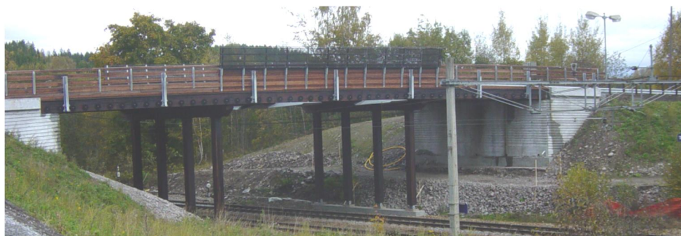
Tangen Bru. Vegbru over Dovrebanen. Stange kommune (2002)
