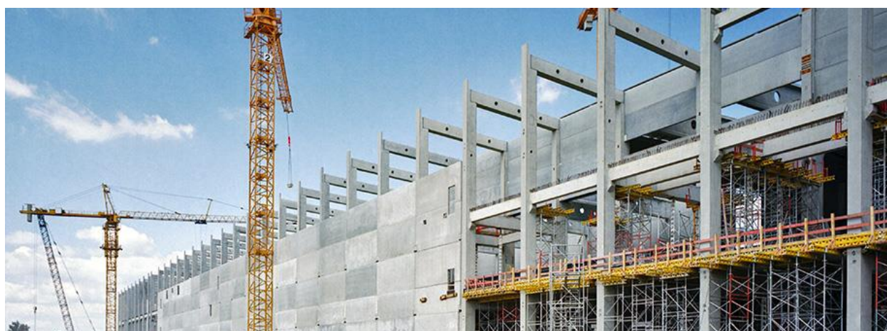
Figur 4 - Stor betongkonstruksjon (Gcp, 2020).
