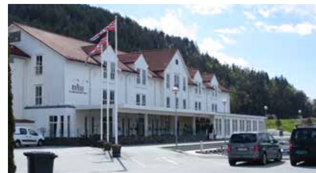
Figur 4.20 Ryfylke Fjordhotell er både godt tilpasset til det bygde miljøet og godt vedlikeholdt (K. Hjorteland)
