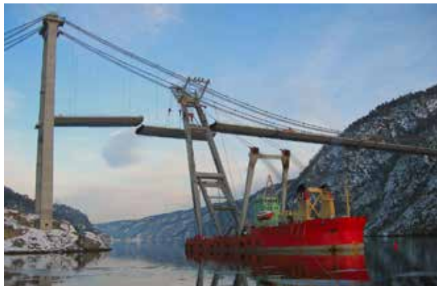
Figur 4.63 Bygging av Fedafjorden bru i sammenheng med omlaggingen av E39 (Viken, 2008)
