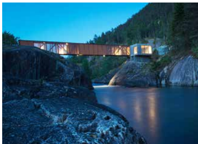
Figur 4.51 Høse bru over Suldalslågen (Suldal Foto)
