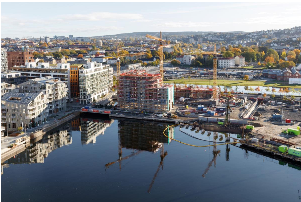
Figur 11 Vedal sitt prosjekt i Bispevika i tidlig fase sett fra retning Munchmuseet. Her ser man hvor tett det faktisk er mot fjorden, og at det vil kunne bli logistiske problemer dersom det ikke er planlagt godt nok. Med tillatelse fra Vedal (ukjent dato) av Vedal.
