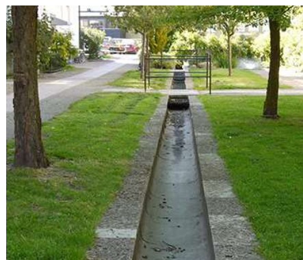
Fig. 45: Vannkanal med overgang. Hentet fra: https://www.ngu.no/grunnvanninorge/arealforvaltning/klimatilpasning/overvannshandtering
