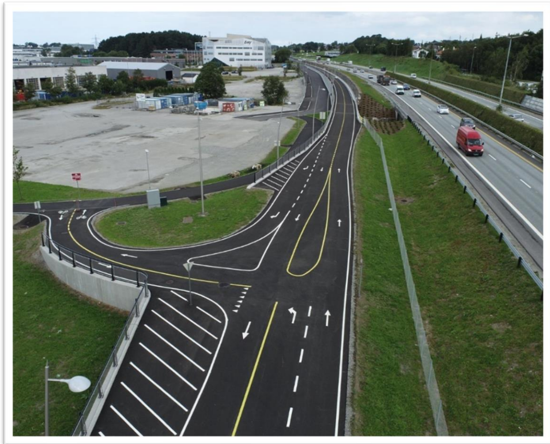
Figur 9: Bilde viser et påkoblingspunkt på Forus i delområde 3. krysset er tydelig markert med farge, oppmerking og skilt. Kilde: Statens Vegvesen
