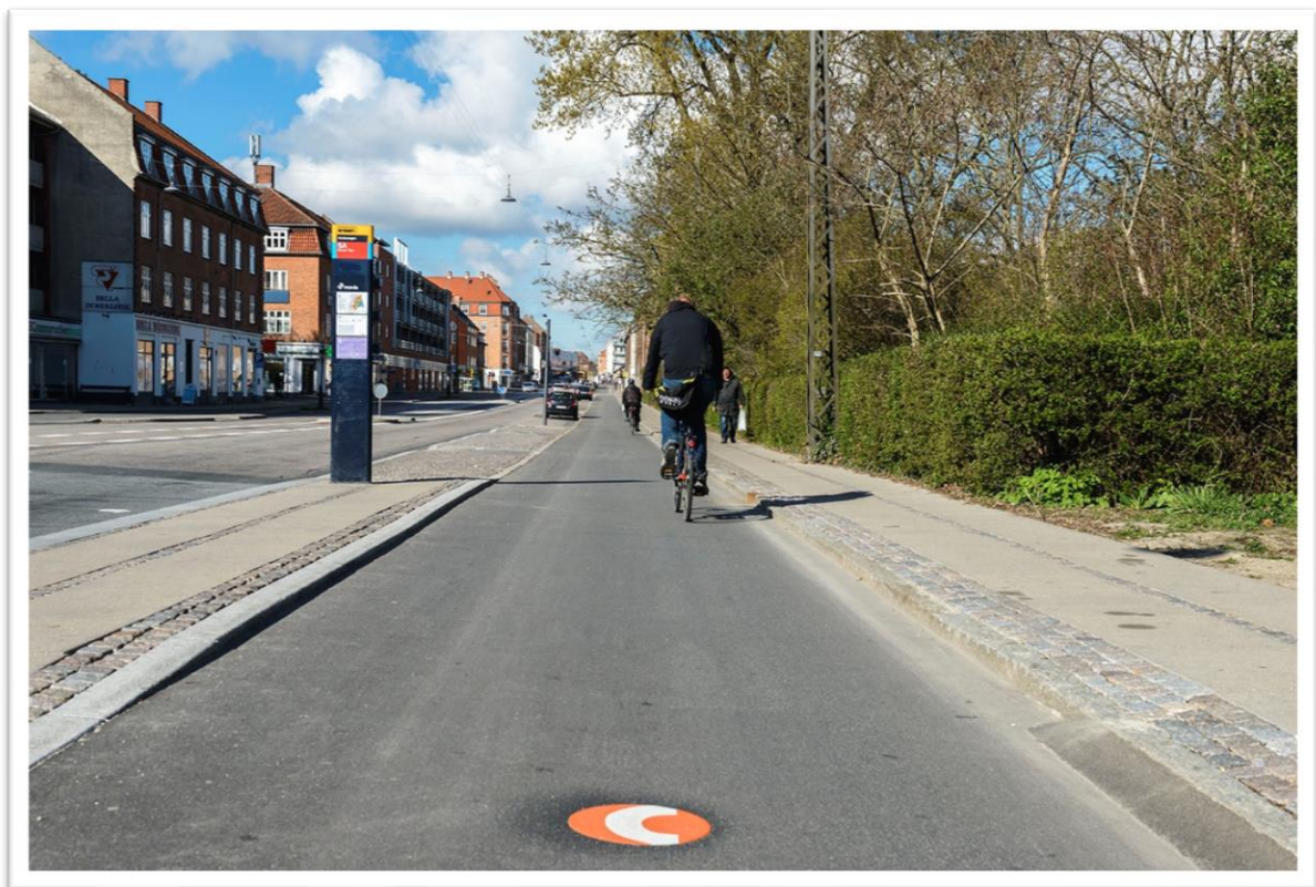
Figur 59: Viser asfalt markeringer og illustrasjon av sykkelstamvegen i Danmark med belegningsstein som viser fysisk skille mellom sykkelvei og fortau. På SSS er det tilrettelagt rekkverk som skiller gående og syklende mye mer effektivt. Kilde:
