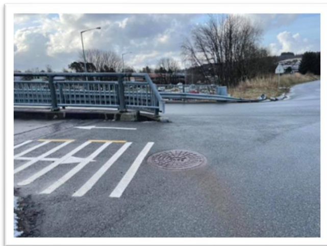
Figur 46: Foto av kjørebane, gang- og sykkelbru ved Sørmarka Arena.
