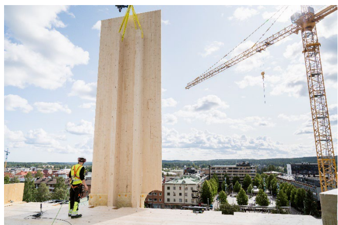
Figur 2: Massivtreelement som heises på plass i Skellefteås kulturhus i Sverige. Foto: Martinsons / Jonas Westling
