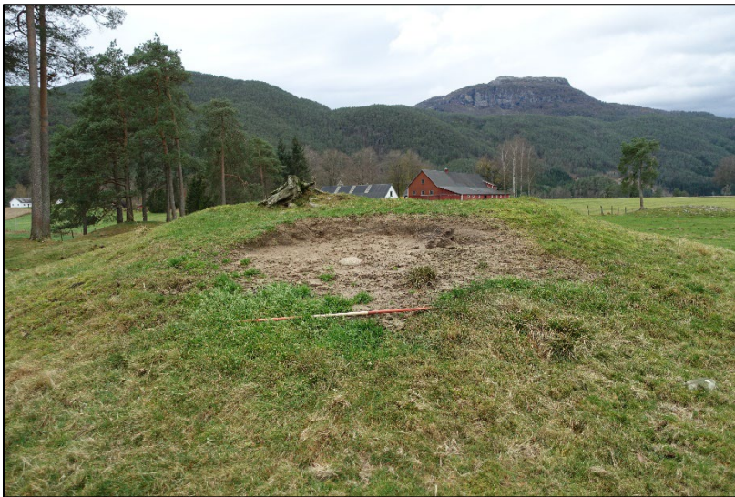
Figur 4 Status for del av -34 før sikring. Foto mot N.
