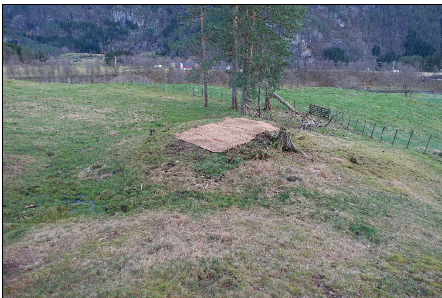
Figur 7 Døme på status ved fullført sikring med rulleplen og kokosnett, her ved røys -36. Foto mot S.
