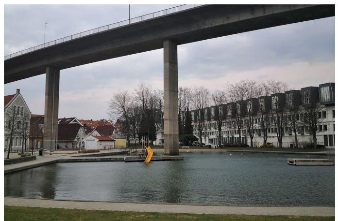
Foto 28 - Overblikk over badedam. En ser ei sklie som ledar ned i vatnet.
