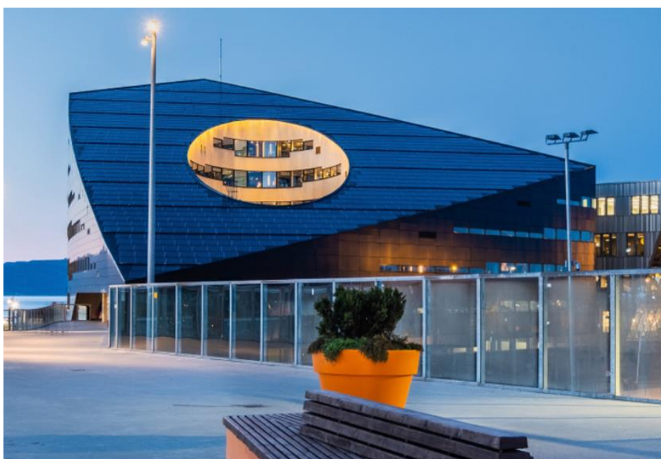
Figur 10: Powerhouse på Brattørkaia 17 i Trondheim (Entra, u.å.b).
