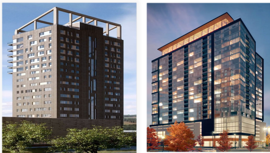
Figur 1: Mjøstårnet til høyre (Utklipp fra Mjøstårn prospekt (DNB Eiendom, 2016)
