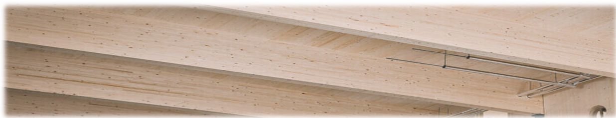
Figur 9: Ribbe-element; limtre er brukt som bjelkelag/avstivere under et dekke av massivtre (Splitkon)
