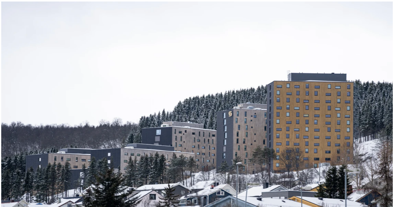
Figur 14: Studentbolig i Smørbukklia Tromsø av massivtre .Totalt 13 etasjer hvor 2 etasjer er i plaststøpt betong/stål og 11 etasjer i massivtre (Woodcon, u.å)
