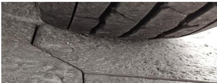
Figur 103 En liten høydeforskjell, anslagsvis på rundt 3-4 mm, ble spottet like ved lastpunktet.
