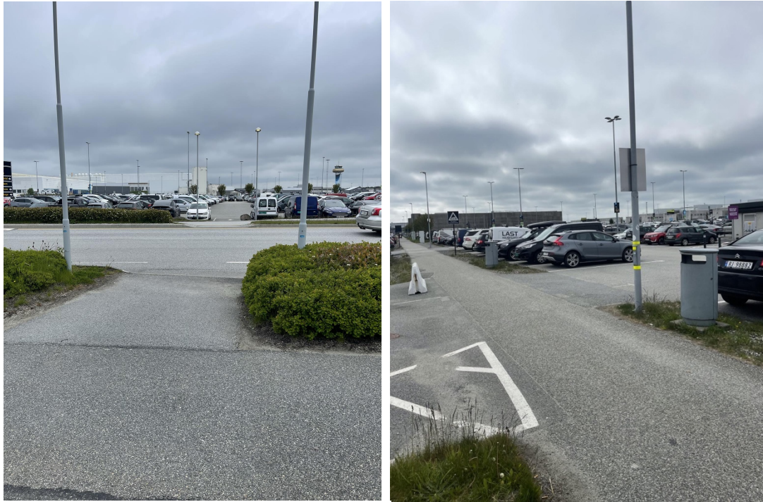
Figur 17 – Sykkelstier med barrierer og mangler
