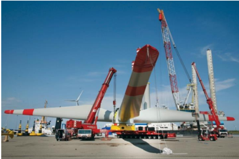
Figure 26. Assembly of the rotor [28].
