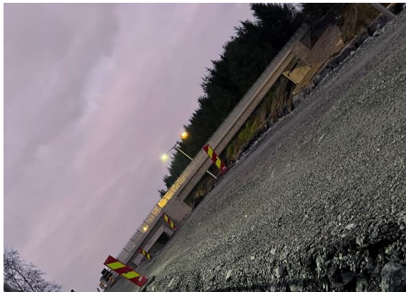
Figur 3-3: Betongbru foreløpig utbyggelse. Eget bilde
