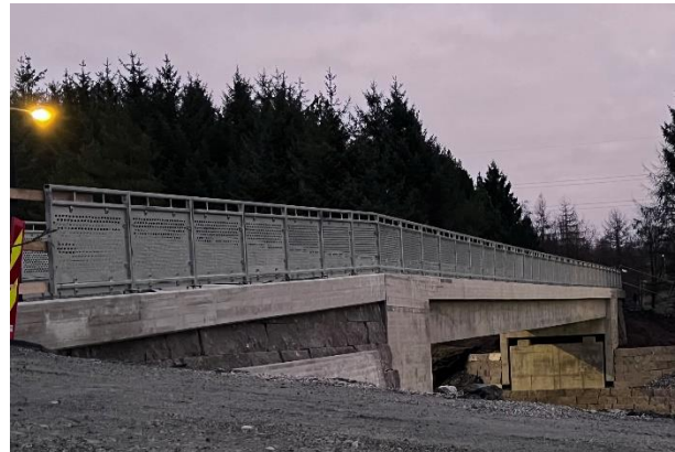
Figur 3-2: Betongbru foreløpig utbyggelse. Eget bilde
