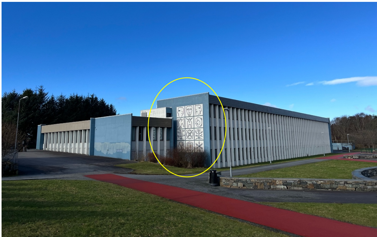
Figur 1 - Haraldsvang skole anno februar 2023. Markert innenfor den gule sirkelen er den aktuelle gjenbruksveggen med kunstverket/relieffene vist
