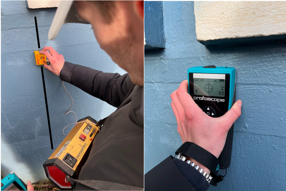
Figur 19 - Bilder fra cover meter test av veggen
