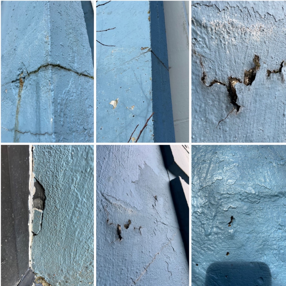
Figur 17 - Bilder fra visuell inspeksjon av veggen
