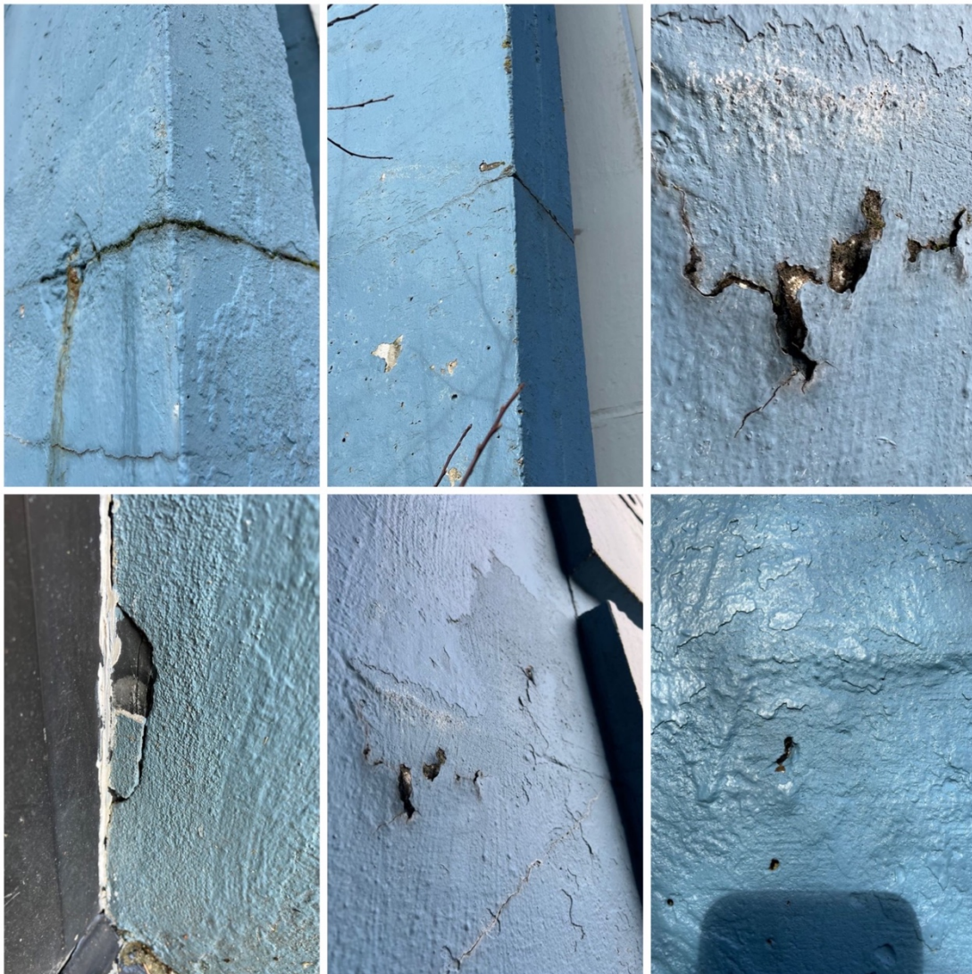
Figur 17 - Bilder fra visuell inspeksjon av veggen
