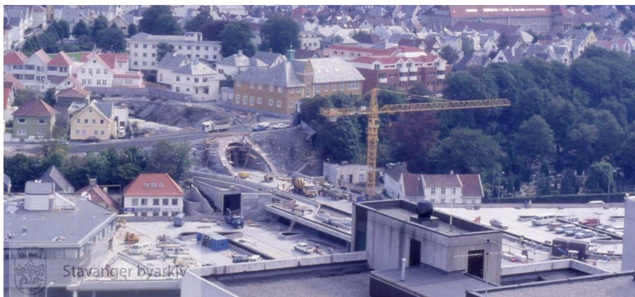
Figur 4.1.7 Bygging av Jernbanelokket, Byterminalen og Bergelandstunellen.
