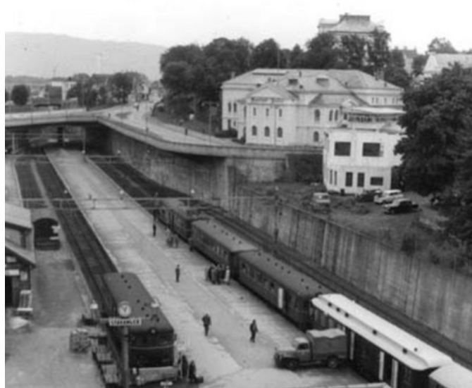
Figur 5.7.5 Utsnitt: "Etter flytting av hovedinngang mot vest. "Stavanger stasjon, oversiktsbilde med motorvogntog i spor 1", ca. 1960-70, av ukjent / Norsk Jernbanemuseum ( https://digitaltmuseum.no/011013107216/stavanger-stasjon-oversiktsbilde-med-motorvogntog-i-spor-1 )
