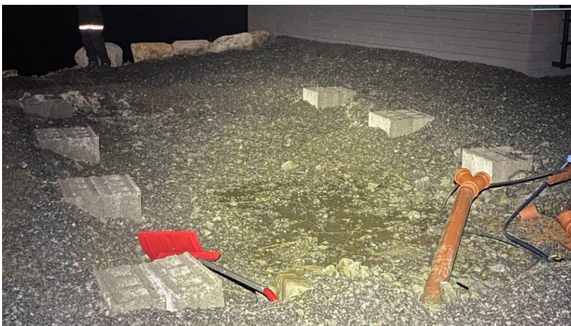
Figur 3.22: Fundamentering av hytta, FOTO: NORDLAND POLITIDISTRIKT [20]
