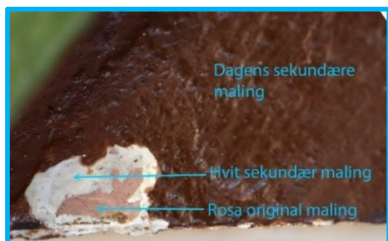
Figur 6 Detaljfoto av skadeområde på gavlfelt. Stratigrafien viser at bakgrunnen er overmalt i minst 2 omganger.
