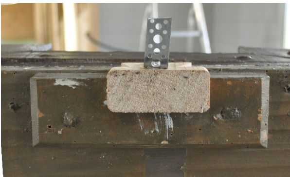
Figur 30 Detaljfoto av svalhaleformede 7 avstandskloss festet i eldre festepunkt på altertavlen. På avstandsklossen er det festet et patentbånd som ble forankret i vegg.
