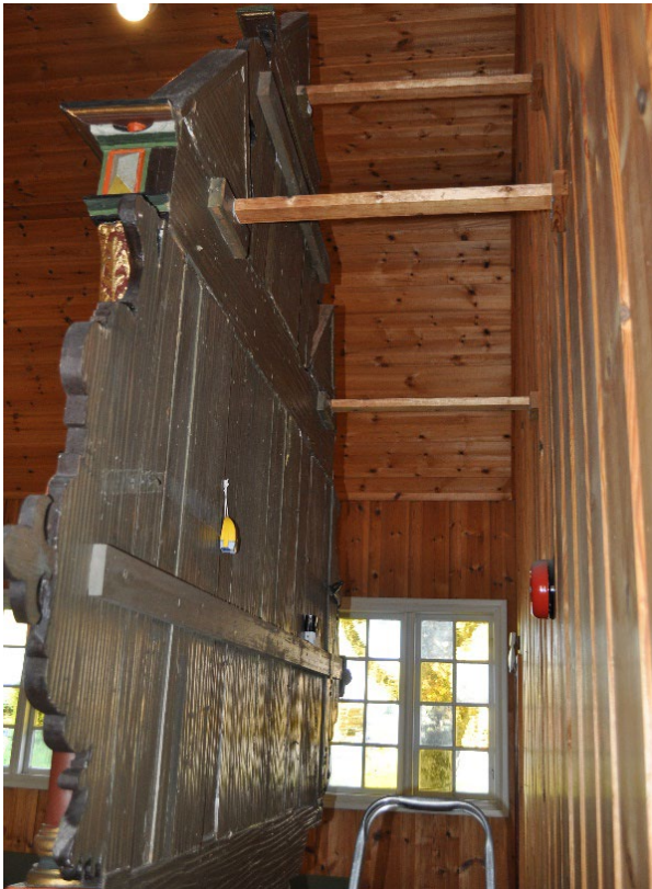
Figur 29 Foto av baksiden på altertavlen før demontering i 2019. Altertavlen var forankret i vegg med 3 planker festet til svalhaleformede klosser i altertavlen. De samme festepunktene ble benyttet ved remontering.
